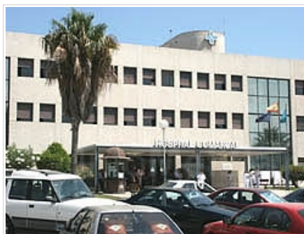
Fachada del Hospital Comarcal de Melilla / Autor: Archivo
